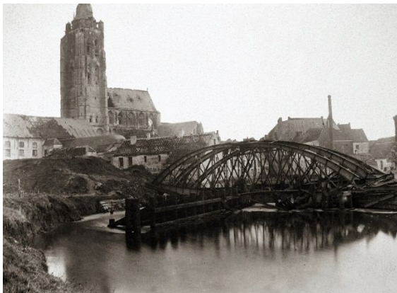
De vernielde spoorwegbrug aan de Meerspoort
