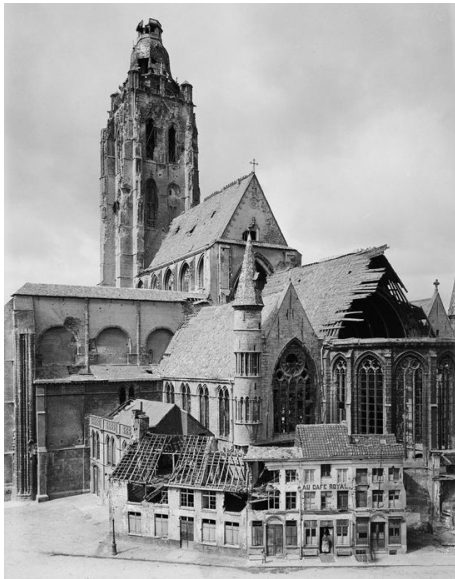
Zicht op de Walburgakerk na het ruimen van het puin
