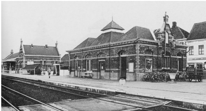
Het dienstgebouw met links de verdwenen goederenloods
